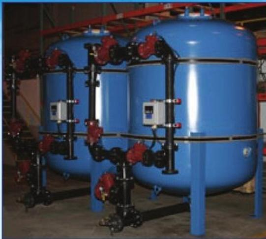
Su içerisinde bulunan Klor, Organik madde, Tat, Koku giderimi işlemlerini gerçekleştirmek için kullanılan Filtrasyon sistemleridir. Proses suyu ve içmesuyu aritimında yoğun olarak kullanılan Sistemlerdir..
